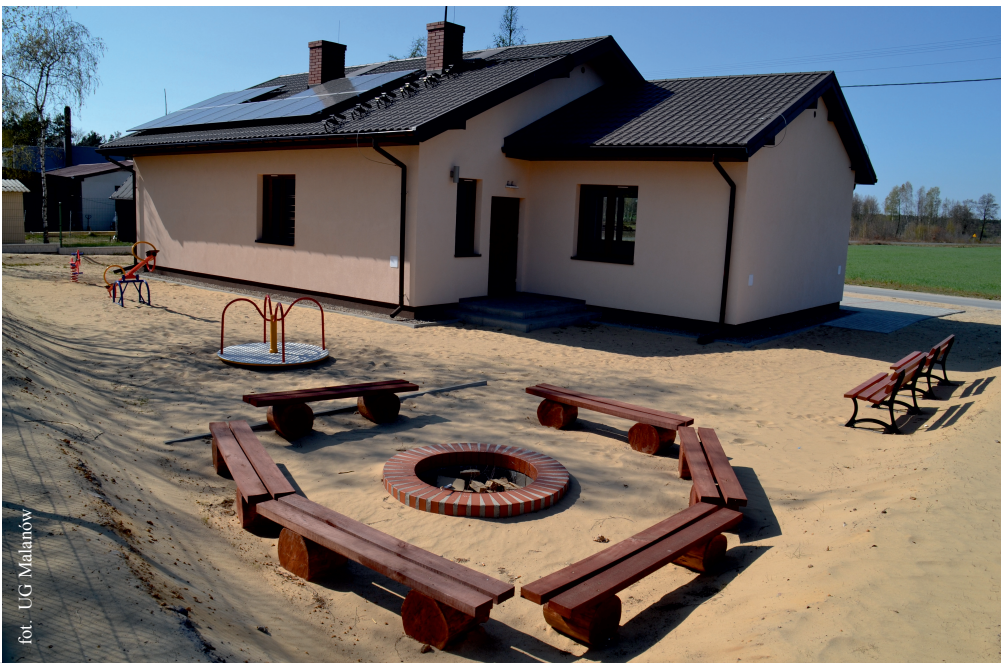
Świetlica Wiejska w Celestynach
